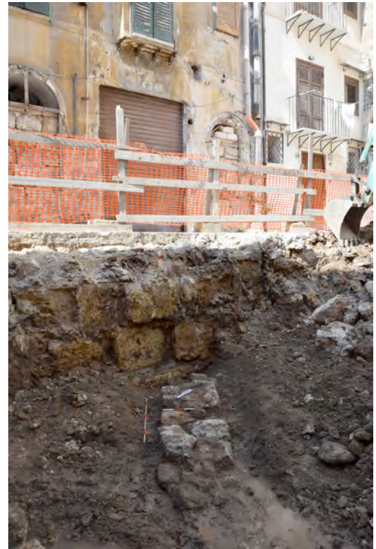
Fig. 24 Struttura muraria a doppio paramento
