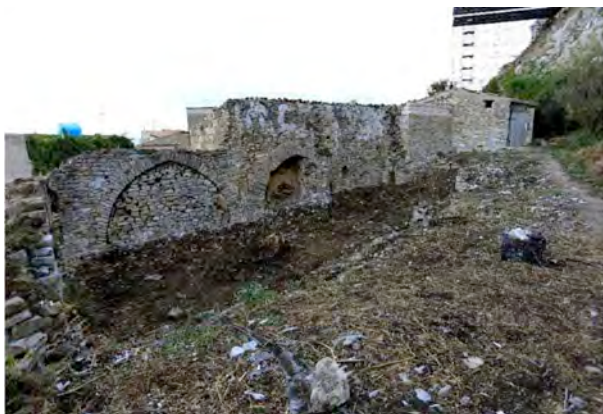
Fig. 79a L'area della Chiesa di Santa Maria di Boikòs all'inizio dello scavo
