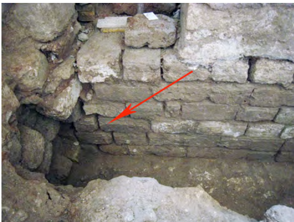
Fig. 9 Sulla sinistra, il canale che taglia i filari inferiori della cortina muraria normanna
