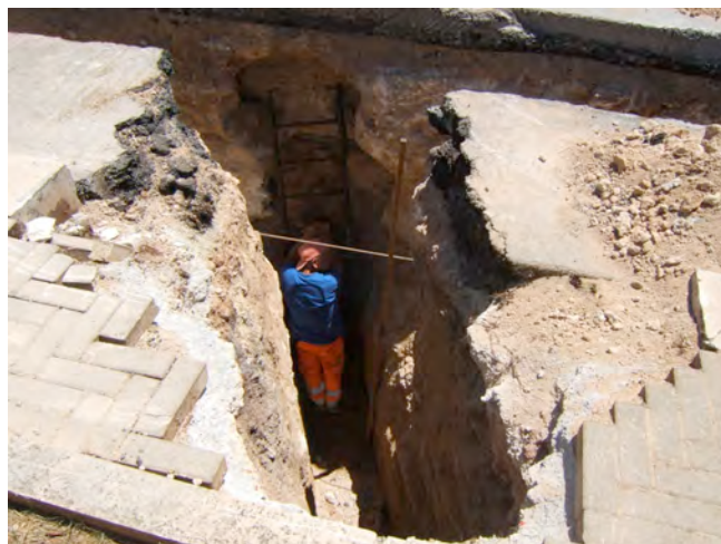
Fig. 37 Tratto del qanat individuato durante i lavori per la posa del cavo dell'alta tensione
