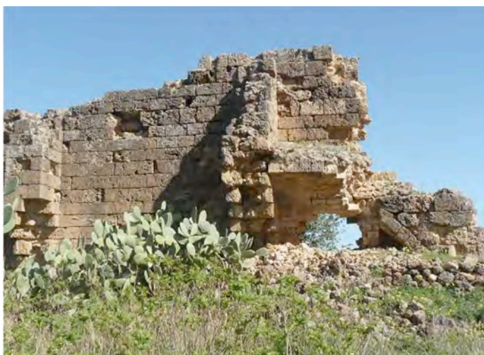
Fig. 51a Il muro sud della chiesa
