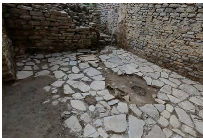
Fig. 78b Pavimento lastricato del vano intermedio della torre occidentale
