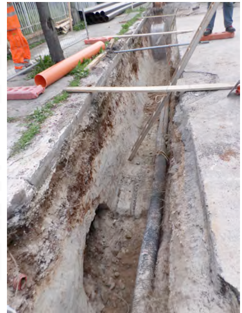
Fig. 40 Trincea con la cella della tomba 1 sulla sinistra
