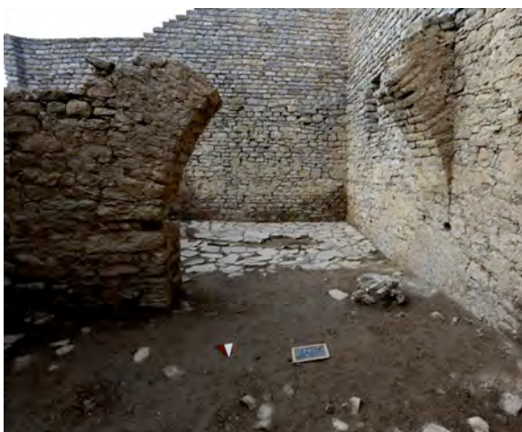
Fig. 78a Vano intermedio della torre occidentale; l'arco a sesto acuto in parte crollato
