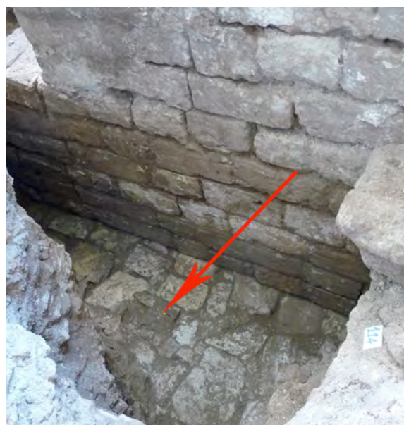
Fig. 3 Particolare del basamento su cui poggia il muro rinvenuto
